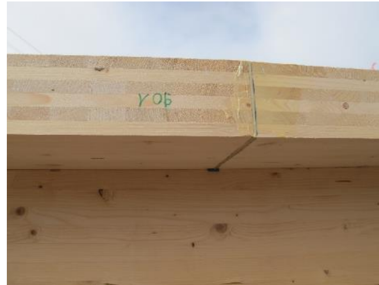
Connexion des panneaux, i.e. CLT
